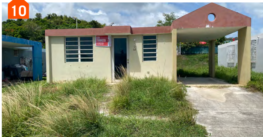
Naguabo, Urb. Vista Verde D-62, Calle Tabonuco, 3H / 2B
